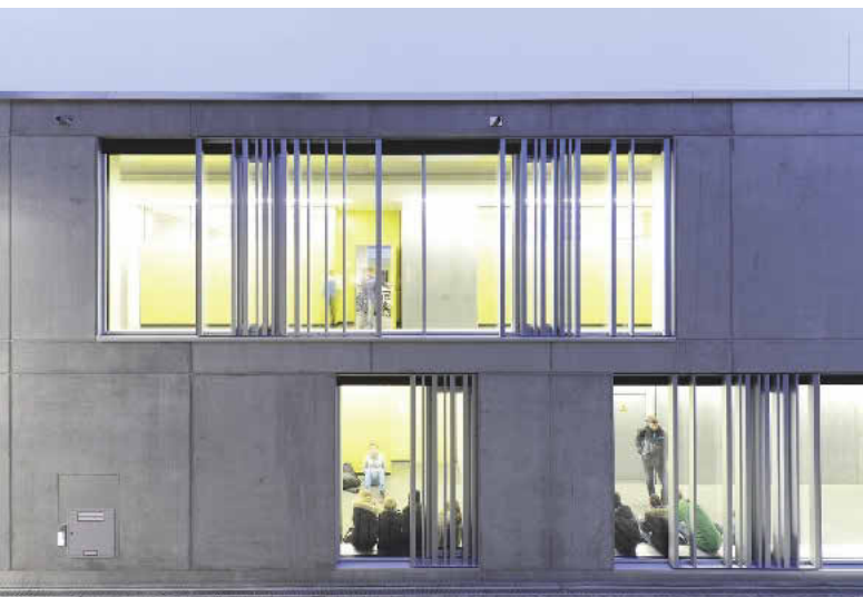
Auf der Gebäuderückseite ermöglichen Öffnungen in den Sichtbetonwänden Einblicke.
