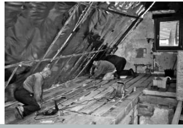
Energiespar-Hülle: Zwischensparren- und Aufdachdämmung plus neue Fenster mit Isoliergläsern.
