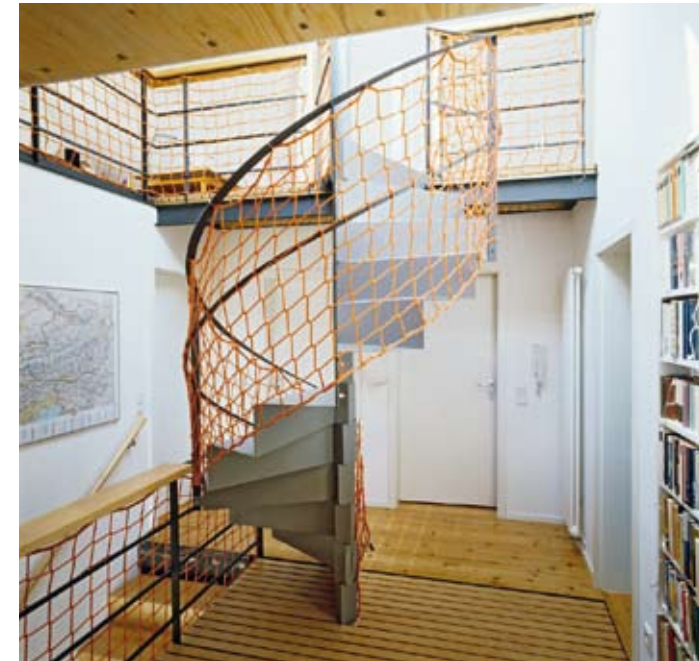
Dank der orangefarbenen Netze können sich hier auch kleine Kinder sicher bewegen. Die Netze lassen sich jederzeit wieder einfach entfernen.
