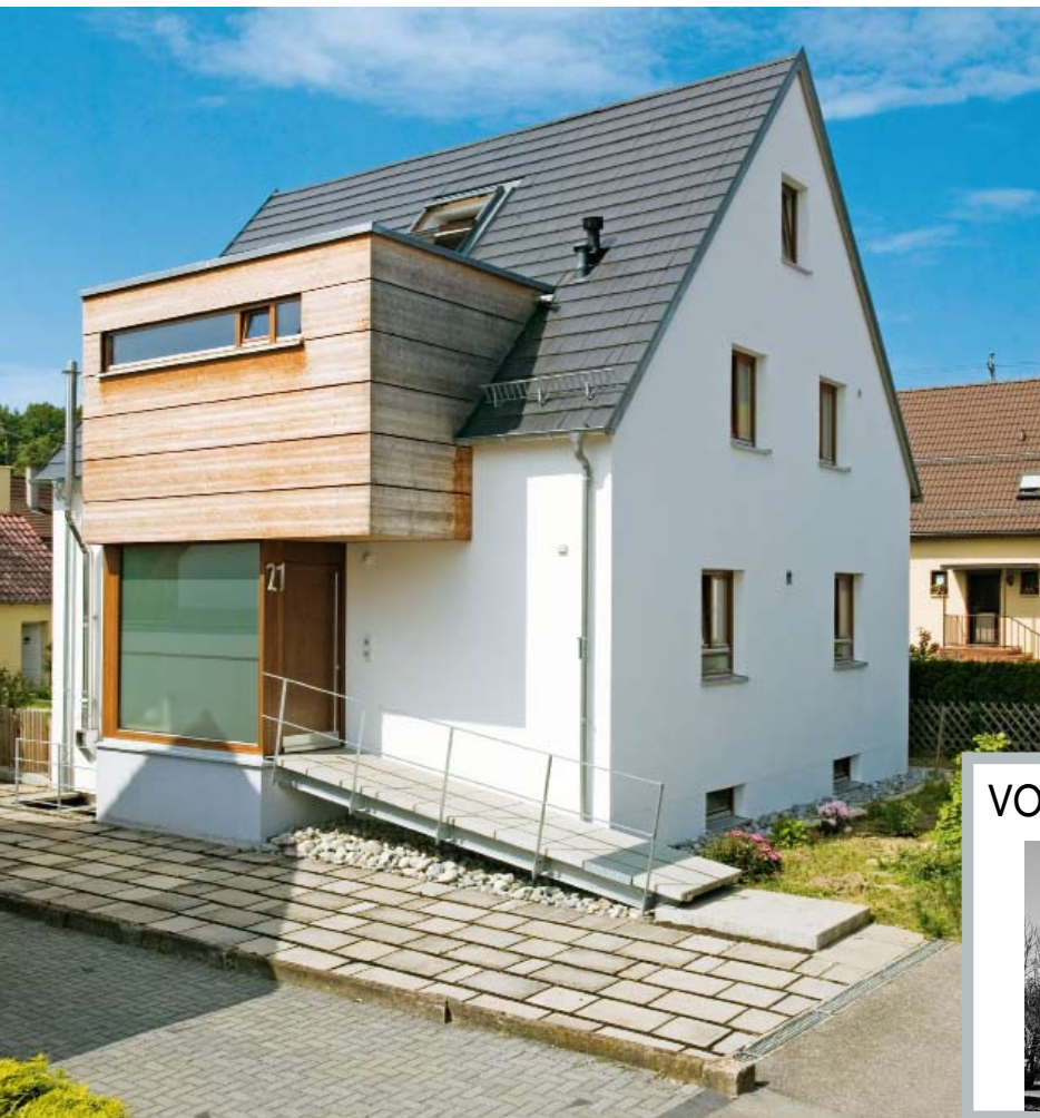
Markant: die neu gestaltete Eingangszone mit Rampe. Die Holzbox bietet Platz für das Ankleidezimmer und eine Dusche.
