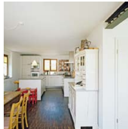
Der Stahlträger rechts oben übernimmt die statische Funktion einer entfernten Zwischenwand.
